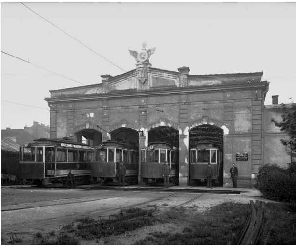
Depo pro tramvaje v Cukrovarnické ulici
